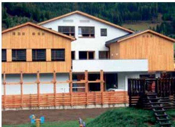
Schon von außen wird offensichtlich: Holz steht in der VS Gnesau im Mittelpunkt
